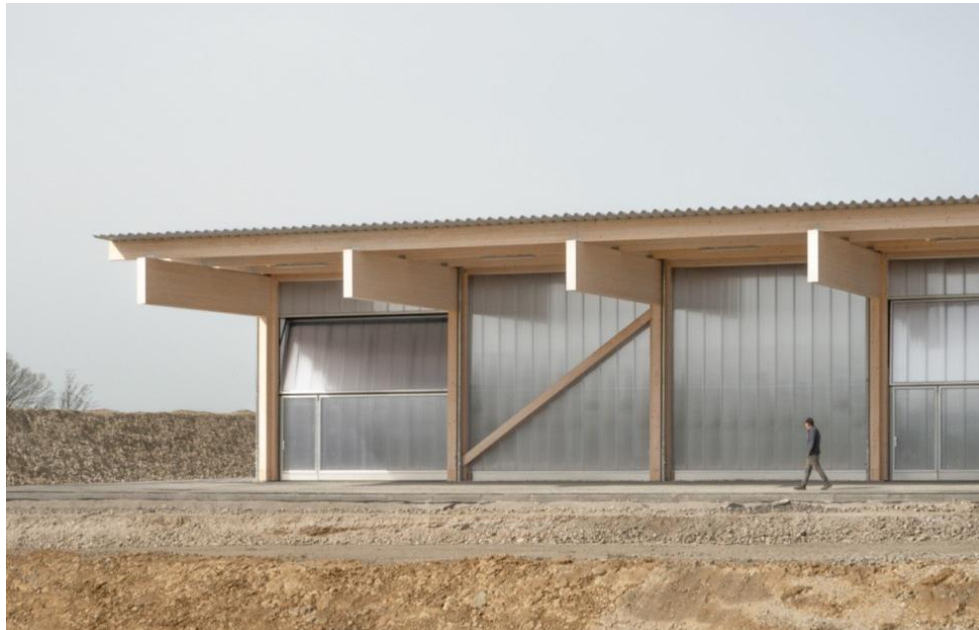
Lärchenholz Fassade, Dach
