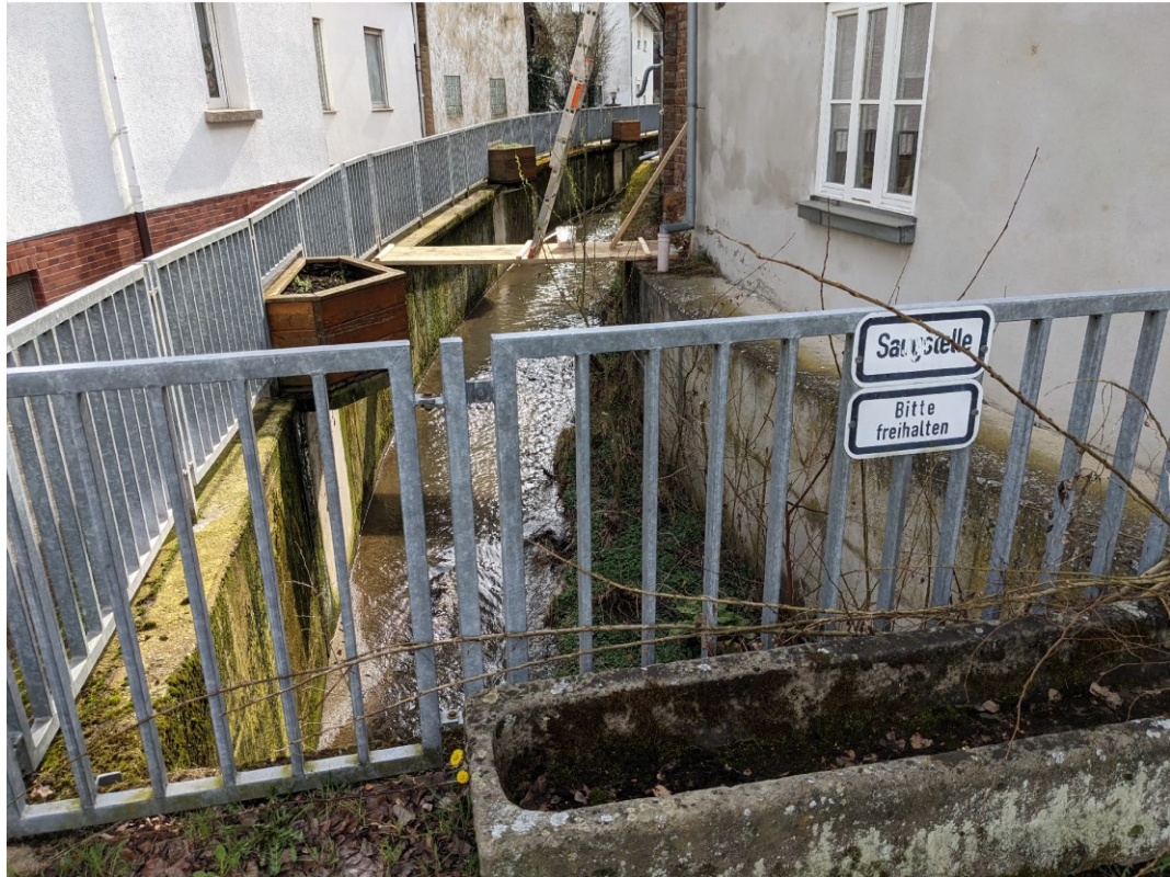
Abbildung 3-3: Blick von Kapersburgstraße in Richtung Bachweg.
