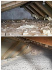
Abbildung 1: Dämmung der obersten Geschossdecke mit Klemmfiz aus Glaswolle (oben) und mit Zelluloseflocken (unten).
