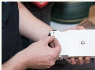
**10** Der HÜP wird mittels eines DG-Siegels verschlossen, um so Eingriffen von außen vorzubeugen. Im Anschluss erfolgt die Verbindung zwischen HÜP und dem Glasfaser-Teilnehmeranschluss (GF-TA). Dieser bildet die Glasfaser-Anschlussdose in ihrer Wohnung.
