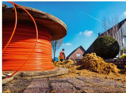
**2** Das Leerrohr – und somit die Voraussetzung für den Glasfaser-Anschluss – liegt nach dem Öffnen des Gehwegs bereits vor Ihrer Haustür. Im nächsten Schritt wird die Glasfaser eingeblasen.
