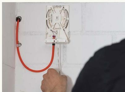
**9** Kennzeichnung des HÜP mit eigener ID. Mittels dieser kann das Gerät eindeutig identifiziert werden, beispielsweise bei der Aktivierung nach einem Umzug.
