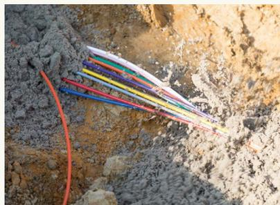
**3** Mithilfe des sogenannten Bodenverdrängungshammers unter dem Garten bzw. der Einfahrt hindurch bis zum Kopfloch an der Hauswand verlegt. Sollte der Einsatz nicht möglich sein, arbeiten wir in offener Bauweise. Die Möglichkeiten und Details sowie die Position des Kopfloches werden am Tag der Hausbegehung mit Ihnen besprochen. Vorgarten oder Einfahrt bleiben bei diesem Vorgehen unberührt.
